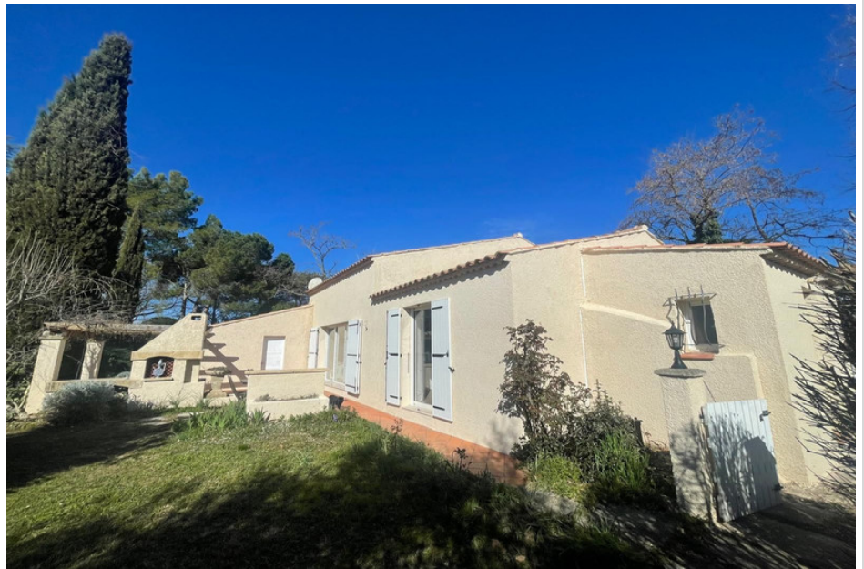
House ref. 889V1598M Pourrières
